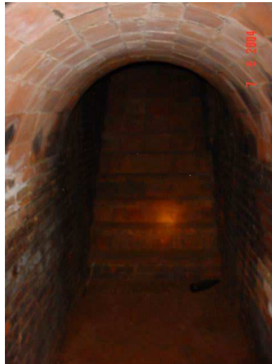
Vista de la volta que forma la cubrició del sostre del refugi. 7-6-2004. (AMC).
