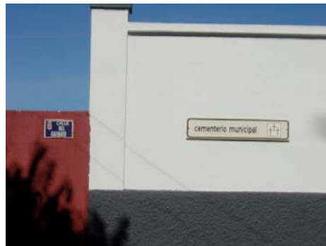
Senyalització de nom d'un edifici amb mala llegibilitat
