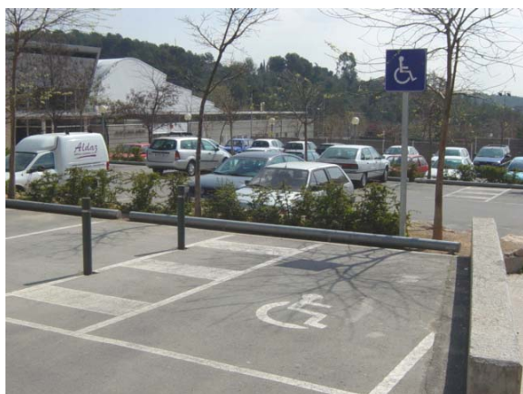
Espai de 1,50 m al costat de la plaça
